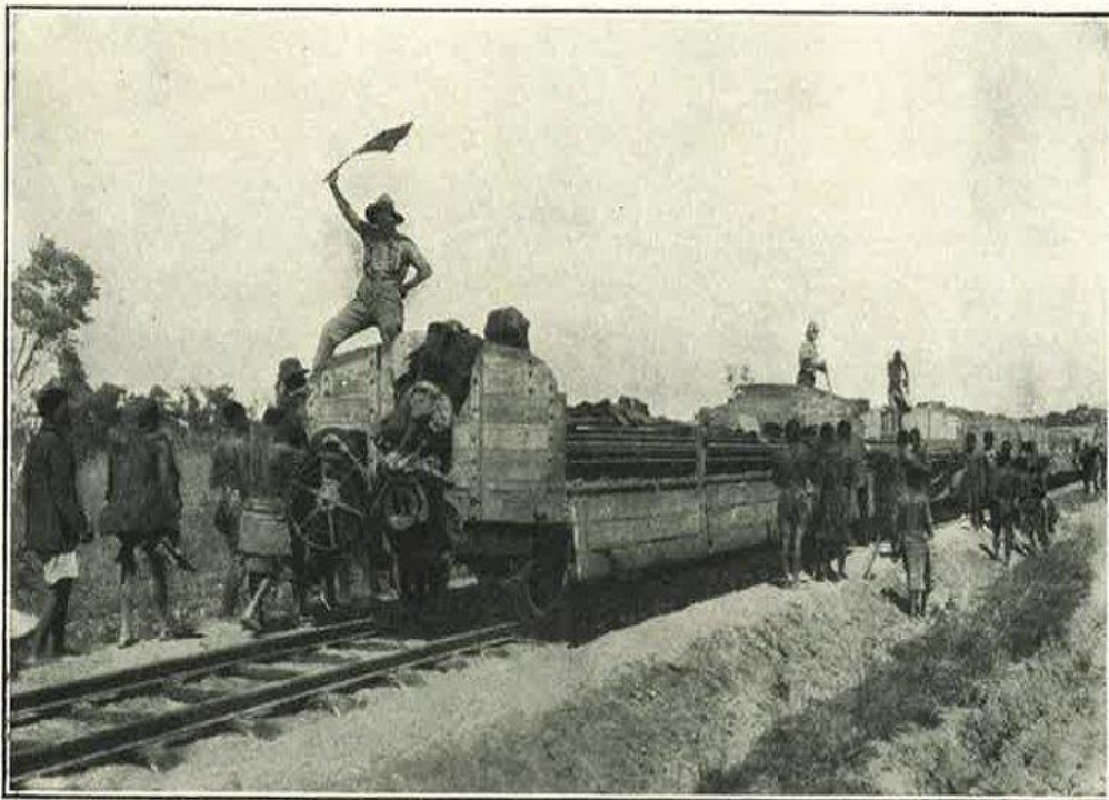
ASSENTAMENTO DE LINHA. COMBOIO DA CONSTRUÇÃO EM MARCHA.
