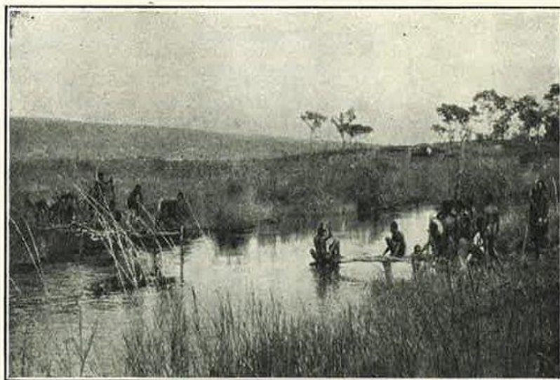
INDIGENAS DE ANGOLA CONSTRUINDO UMA PONTE.
